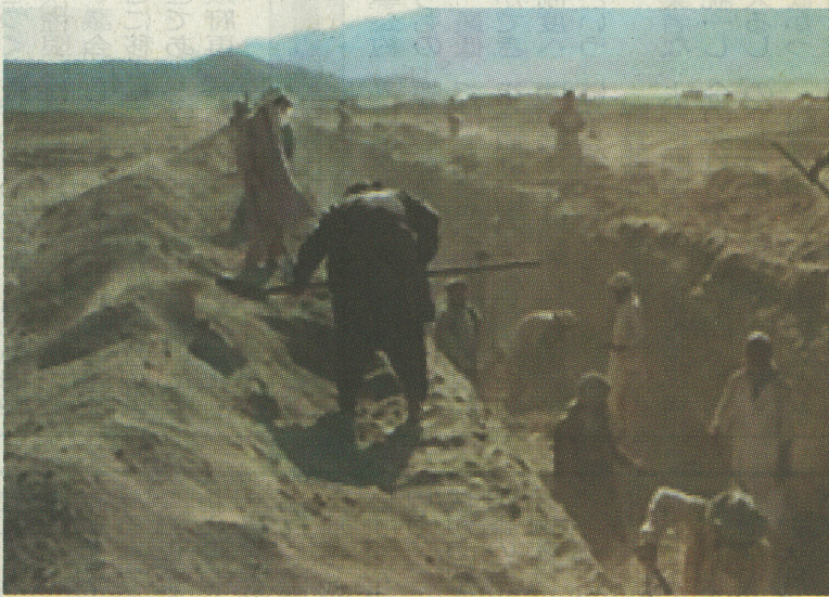
難所である最初の6キロ区間での用水路掘削現場。5000本の柳を水路保護として植栽する予定=9月10日、アフガニスタン
