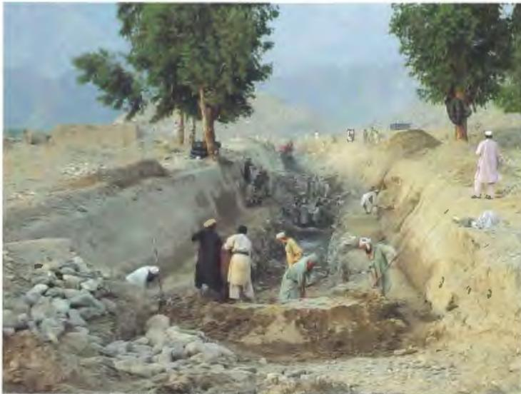
クナール河からの用水路工事。半砂漠化した耕作地に水量の豊富なクナール河から約16kmの用水路をひき、約1500ヘクタールを灌漑する予定。
