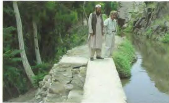
外国団体が補修したコンクリート工事の用水路。コンクリート補修部分は毎年壊れていますが、地元の人では治せなくなっています。左写真の様に土盛り、植林を行えば、地元住民が自分達で管理できます。
