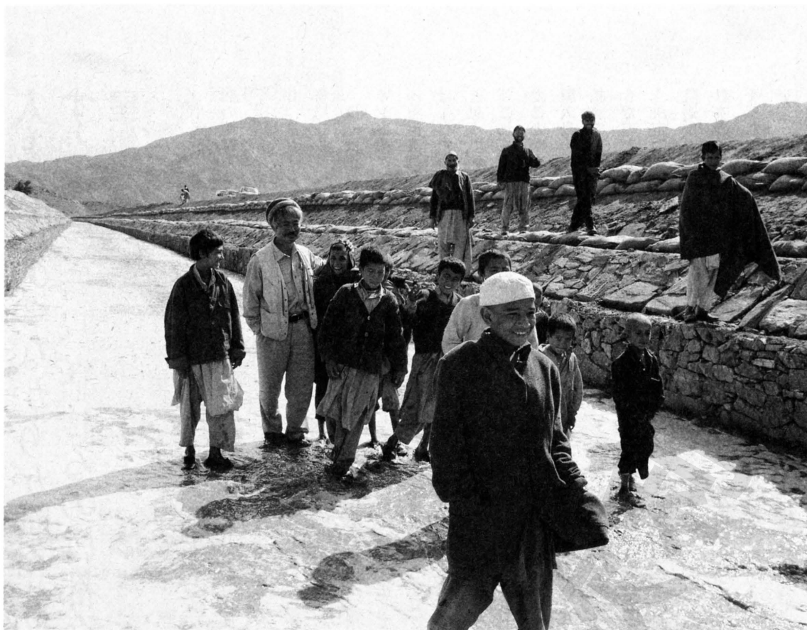
通水の堰が切れ、ひたひたと満ちてくる水に子どもたちの歓声が。用水路は完成すると全長14kmになる。「医者を100人連れて来より、1本の水路です」。コンクリートを使わず、現地の人でもメンテナンス可能な「蛇籠」による護岸工事は環境にもいい。土手には柳や桑を植える。
