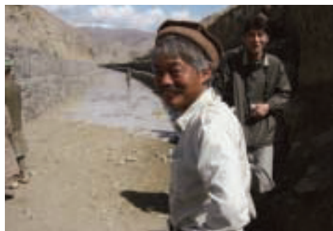
2004年2月、アフガニスタンのマルワリード用水路第一期工事の現場で。photo: ペシヤワール会
