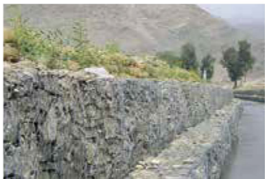
写真左/蛇籠を重ねた水路壁を築き出し、竹や藤、鉄線などを丸く長軸に編み中に河原石や砕石を詰め込んで、治水および護岸のための土木資材として古くから利用されてきた。一般的に屈撓性や透水性に優れ、運搬・貯蔵・撤去が容易で経済的であるという利点がある。
