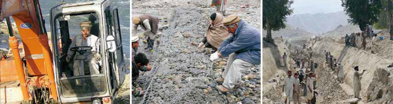
写真左/用水路工事のユンボ操作 写真中央/護洋用の蛇籠を修繕する中村医師 写真右/用水路の作業現場
