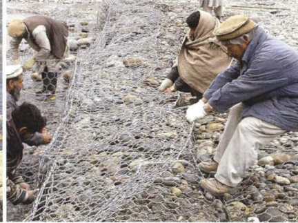
写真左／水路工事のユンボ操作 写真中央／護岸用の蛇籠を修繕する中村医師 写真右／水路の作業現場
