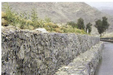
写真左 蛇籠を重ねた水路壁と芽を出した柳
