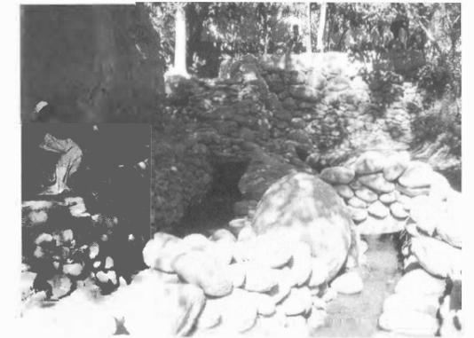
写真に写っているのはカレーズと呼ばれるもので、アフガニスタンの山間部では普通に見られる伝統的な灌漑方法で、簡単に言うと横井戸です。山の斜面へ、水平に穴を掘り進め、地下水脈を水平に導き出すというものです。
