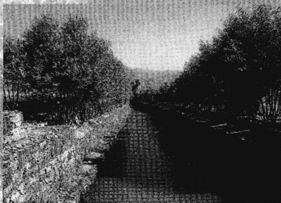
江戸時代の先人の知恵に学んだ蛇籠で護岸し、岸に植えた柳の根が蛇籠をしっかりと捕強し、激しい土石流でも水路決壊を食い止めた。
