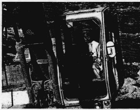
用水路の建設は、シャベルで掘り、岩を一個ずつ積み上げる昔ながらの蛇籠（じゃかご）工が基本（下）。時には中村さんが自ら重機を操って工事を進める（右）。
