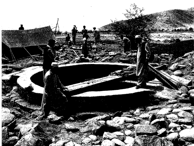
灌漑用井戸の建設
