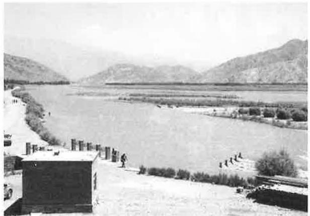
堰幅444mのミラーン堰全景。取水口に向かう河道が安定するよう、護岸には多数の石出し水制が施された。砂州上にはヤナギによる粗朶（そだ）柵工が見られる。（2017年6月14日）
