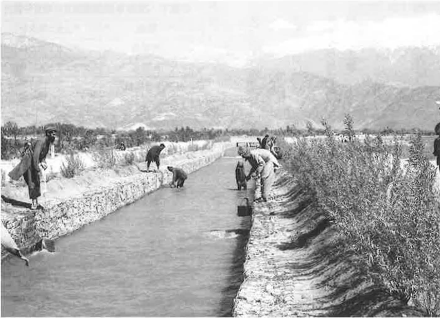
カチャラ、コーティ、タラーン、ペラ村に安定した灌漑をもたらすマルワリードⅡ用水路。兩岸の柳への水やりに勤しむ(2019年3月28日)
