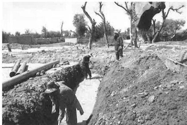
シギ排水路工事風景。軟弱地盤であるため地盤改良に苦戦しているが、排水効果はめざましい。周りのガズは根腐れし、枯死している(2019年5月7日)
