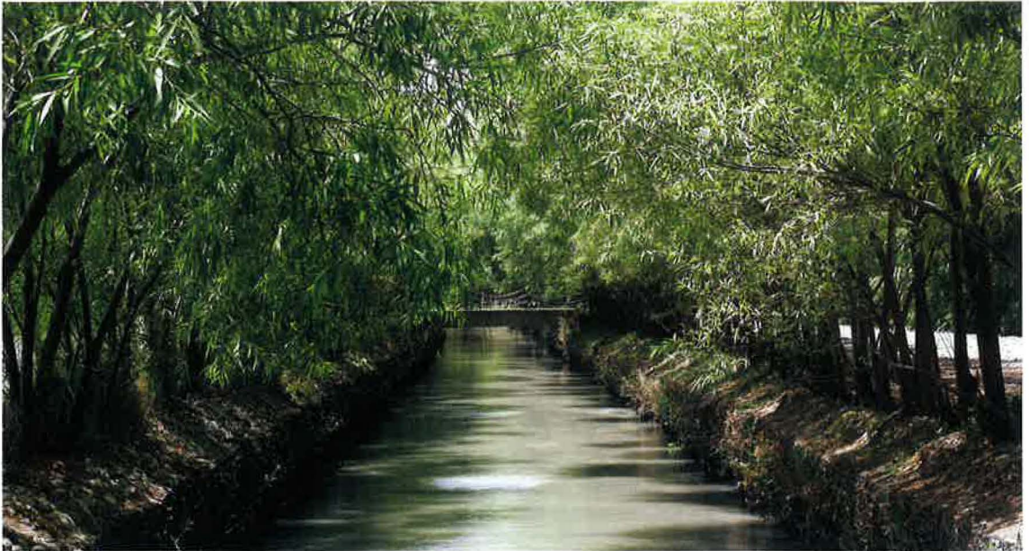
▲開通後8年を経過したマルワリード用水路・ガンベリ沙漠横断路。昔からあったような風格。ヤナギの根が「生きた網」を形成し、蛇籠壁をより強固なものにしている。水量は豊富でシギ下流域まで潤す(2017年7月3日)
