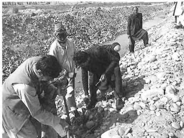
マルワールドⅡ堰の排水路建設現場で柳枝工を実際に行っている研修生たち(2019年5月30日)
