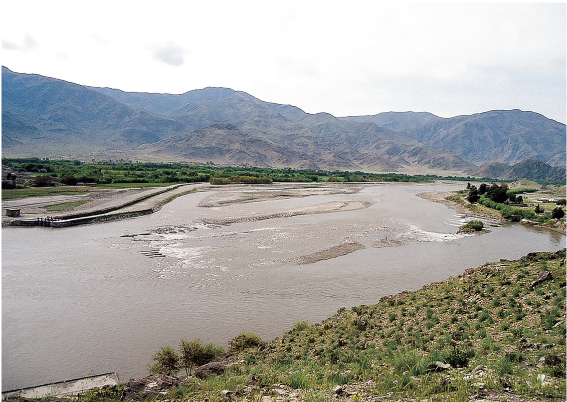
マルワリード=カシコート連続堰全景。全堰幅(越流線)は505m、堰の面積は約25,000㎡にまで及ぶ。シェイワ郡の田畑約4,700ヘクタールを潤している(2014年4月)
