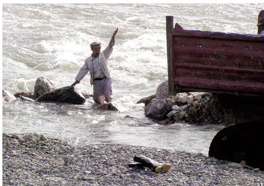
堰の造成工事で河に投入する巨礫を積んだダンプカーを誘導する中村医師(2004年3月)
