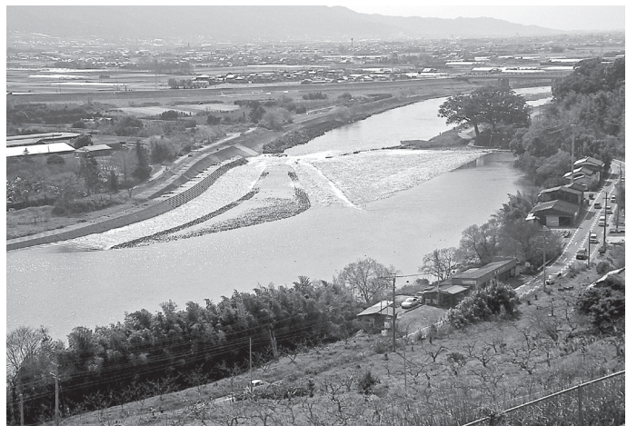
PMS方式取水システムのモデルとなった山田堰（福岡県朝倉市）
