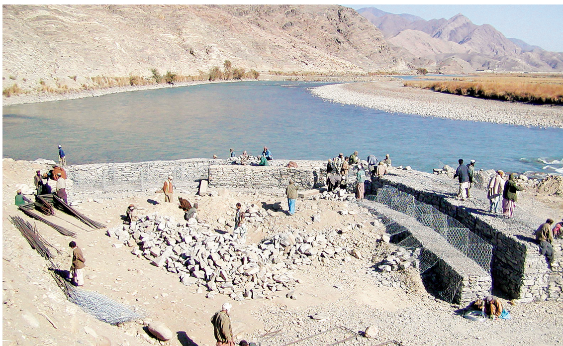
PMSが初めて着手した用水路取水門建設工事開始直後(2004年1月)
