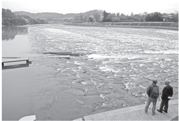
石張り面積25,000㎡の山田堰
