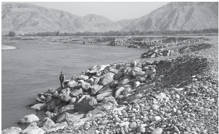
ベラ村の浸食を止めたマルワリードⅡ5.6km地点の護岸。低水位期になって石出し水制による著しい河床低下が見られる。ミラーンでの経験は大きく、この護岸方式が浸食対策の定番となっている（2018年10月29日）
