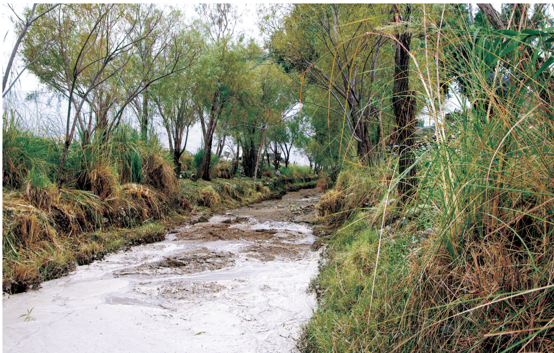
ケシュマンド山麓での集中豪雨による鉄砲水の土砂で埋まったマルワリード用水路（2018年11月1日）
