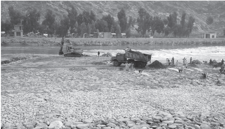
カマ第一堰改修は予定通り進んでいる。今回は砂州との接合部の工夫が主題の一つだ。全体に手際よい作業工程で、作業員は巨礫の取扱い、砂利の活用に習熟している（2018年10月28日）
