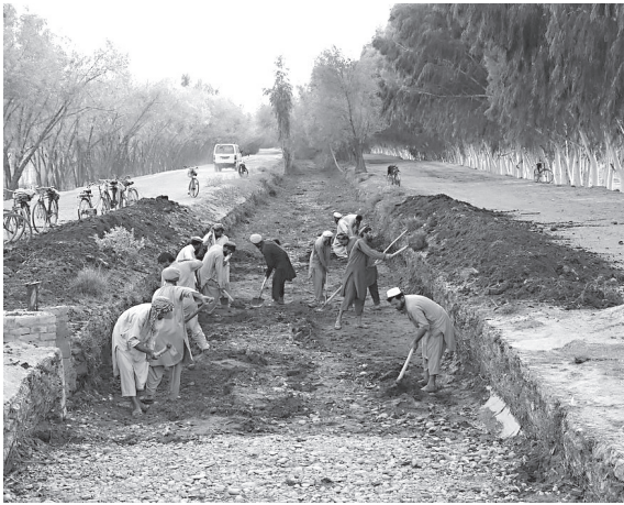
ガンベリ横断路の浸漬。黒い泥土が堆積している。泥土は有機物を含み、肥料として貴重（2018年10月16日）
