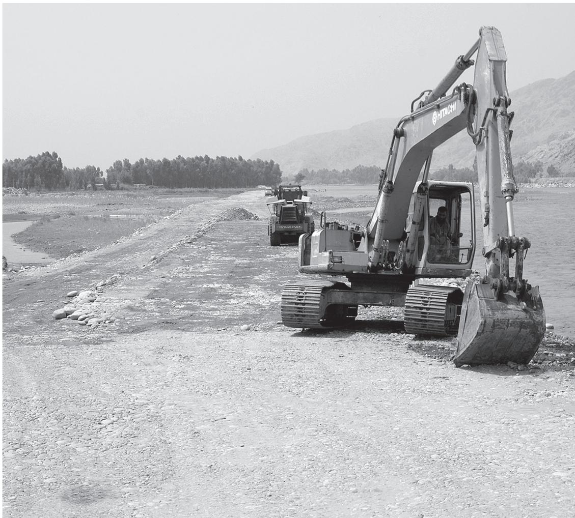
マルワリードⅡの護岸線は全長8.5km。6km以降の護岸工事。締め固めをしながら、ただひたすら土砂や砂利を積む
