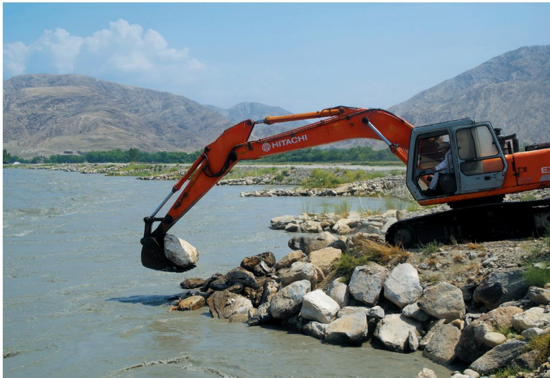
マルワリードⅡ堰の護岸始点から5.5km地点。洗掘の激しい水制先端に巨礫を置く中村医師(2018年7月20日)
