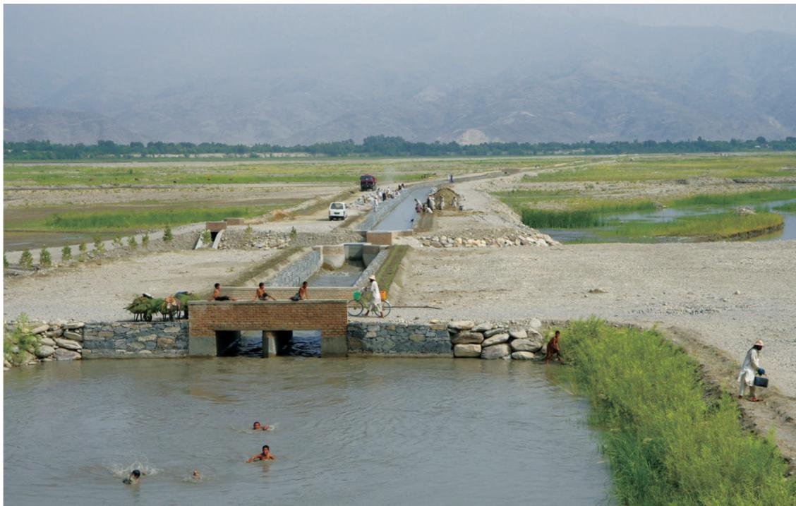
調節池Ⅲ。主要な工事は完了し、二段目の蛇籠積みと水やりが続けられている。憩いの場として美しく仕上げる
