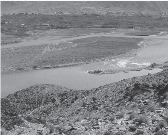
川幅を時には1km、時には約100mに変化させながら蛇行するクナール河取水口の斜め堰(2004年3月1日)
