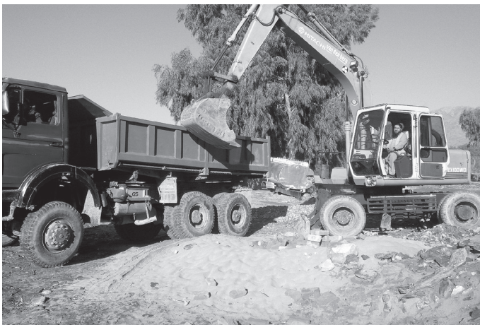
掘削機を操縦中のサマード運転手(2017年11月22日)
