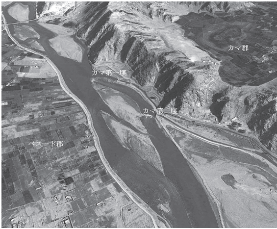
カマ第1堰、第2堰の位置
