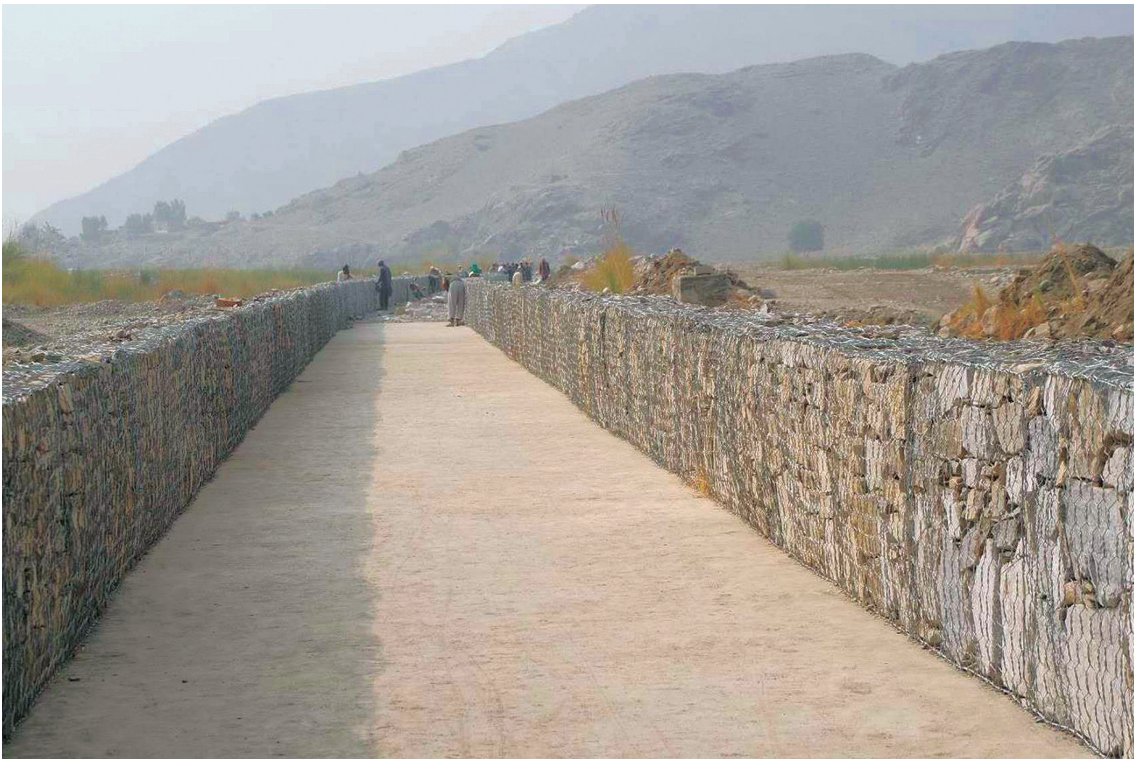
主幹水路3.6km地点。角を埋めつぶすと送水が出来る。蛇籠の2段目は、送水しながらでも積める(2017年11月14日)
