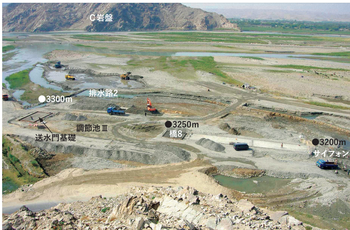
調節池Ⅲ上流側を望む。マルワリードⅡ用水路の調節池Ⅲの造成と同時進行で送水門やサイフォン、橋、主幹水路の延長が進められている。排水路は一時河側へ導き、サイフォン建設後に元の位置へ戻す(2017年10月19日)
