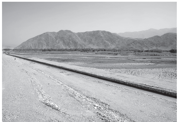
マルワリードⅡ用水路調節池ⅠからⅡ池までの主幹水路。通水後でも蛇籠２段目を積む作業や柳の挿し木は出来る。早期の灌漑を必要としているため水路工事は下流域へと進行中(2017年9月26日)
