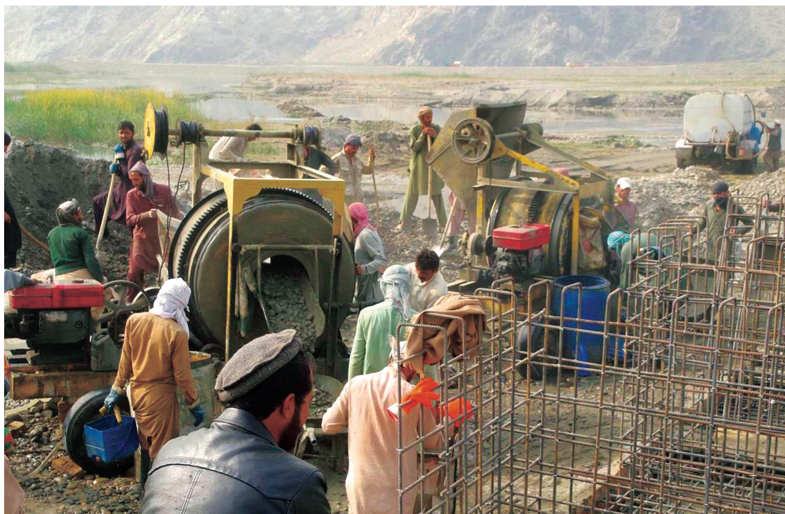
調節池Ⅲの送水門建設。コンクリート構造物が多く忙しい(2017年11月14日)
