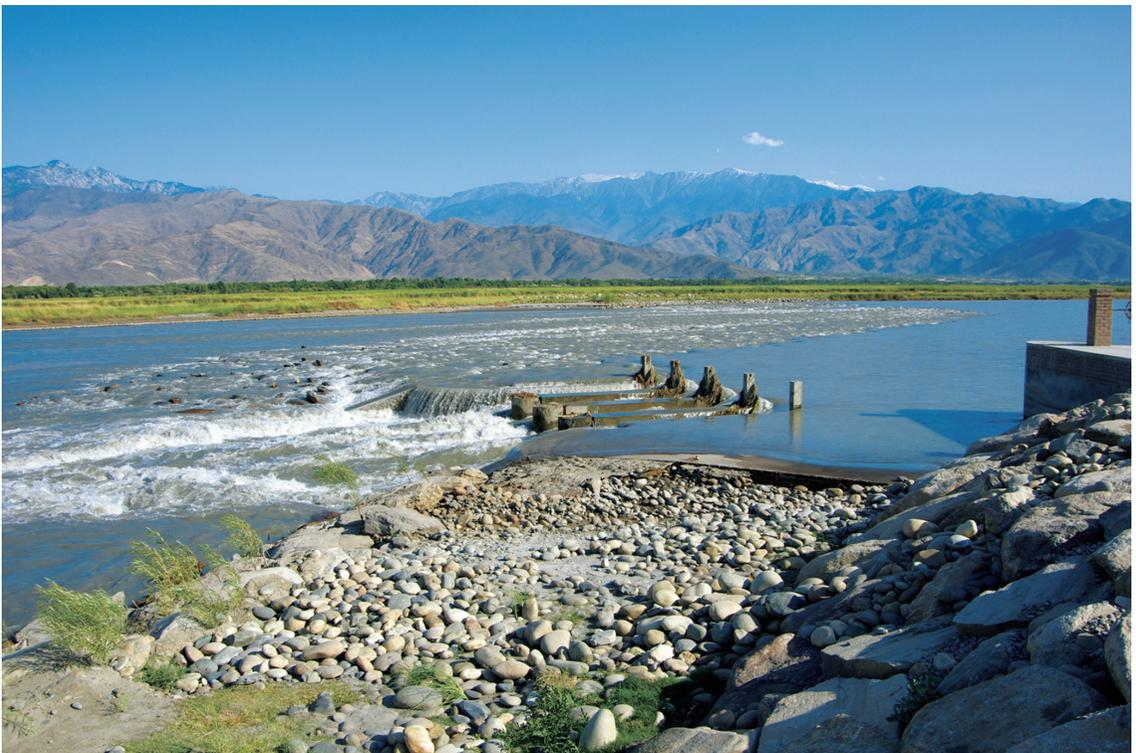
一夏を経験したマルワリードⅡ斜め堰、右側が取水門、そのすぐ左に土砂吐き兼可動堰が造られた(2017年9月17日)
