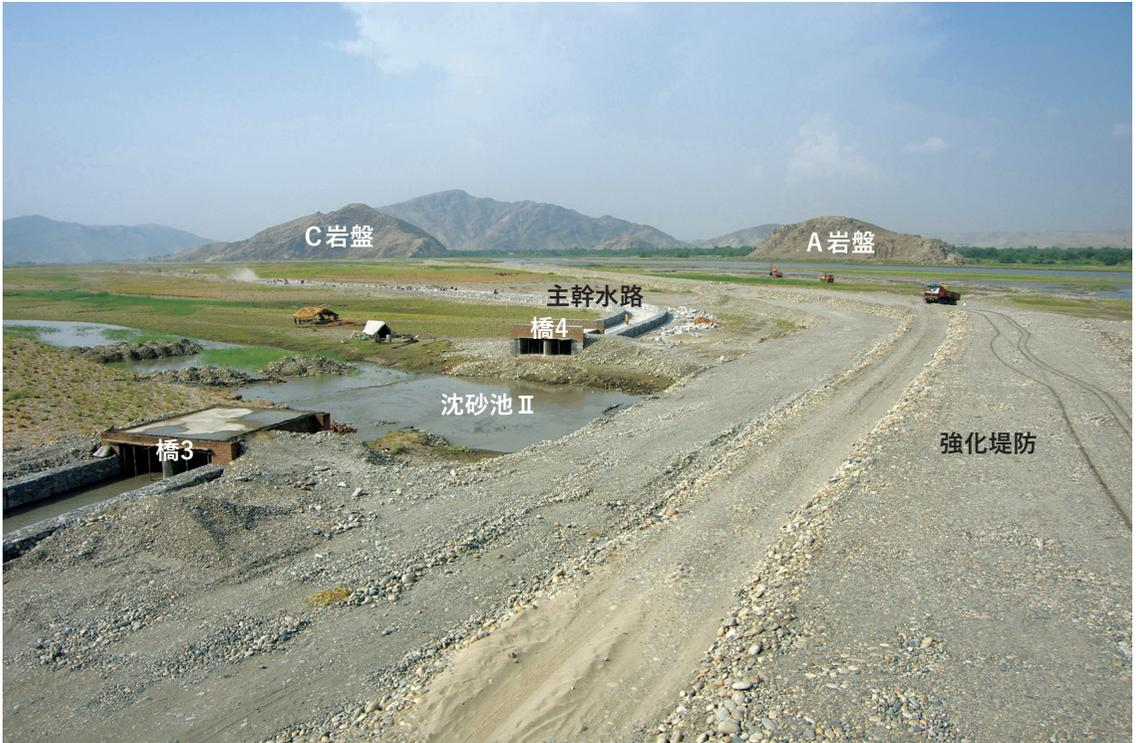
マルワリードⅡ用水路1500m地点(洪水流入地点)に造成中の沈砂池Ⅱ＝緩衝池。池から送水される主幹水路の基礎造成が進行中。強化堤防は300mの基礎を終えた。堤防は過度に高くせず、最悪でも「緩やかな溢水」とし、池で吸収(2017年8月13日)。
