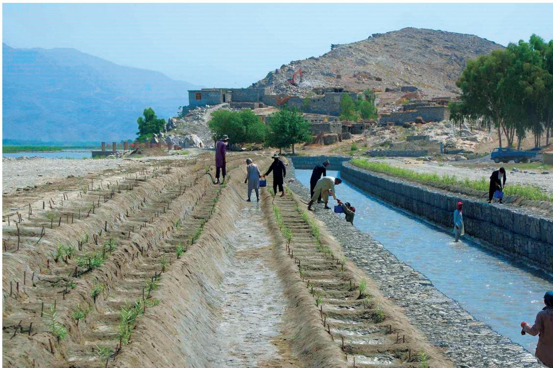
マルワリードⅡ用水路200m地点の植樹作業。1㎡あたりに約10本、シルトと砂質の混合土に挿し、ポンプを使わずバケツでひたすら水をやる。活着率95%以上（2017年6月12日）
