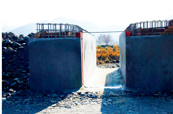
沈砂池の構造物。本水路への送水門(右上)、コーティ村への送水門(右下)、排水門1(左上)、排水門2(左下)
