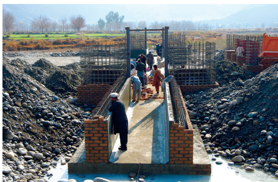
沈砂池の構造物。本水路への送水門(右上)、コーティ村への送水門(右下)、排水門1(左上)、排水門2(左下)
