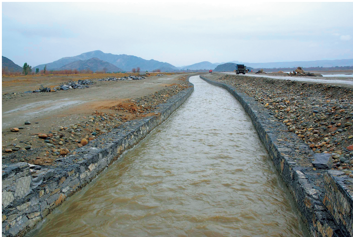
取水門から、水路壁下段の蛇籠工を終えた主幹水路へと送水。上段の蛇籠工も開始され、柳の植樹(柳枝工)も追って施される(2017年1月28日)
