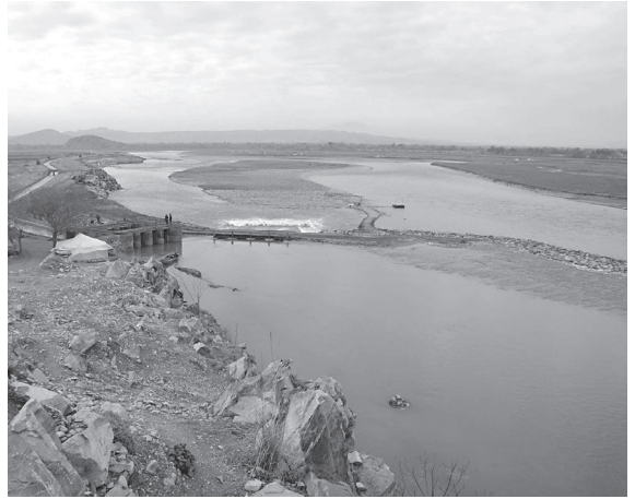
クナール河の本流。堰、取水門、主幹水路(画面左)が見える(2017年1月)
