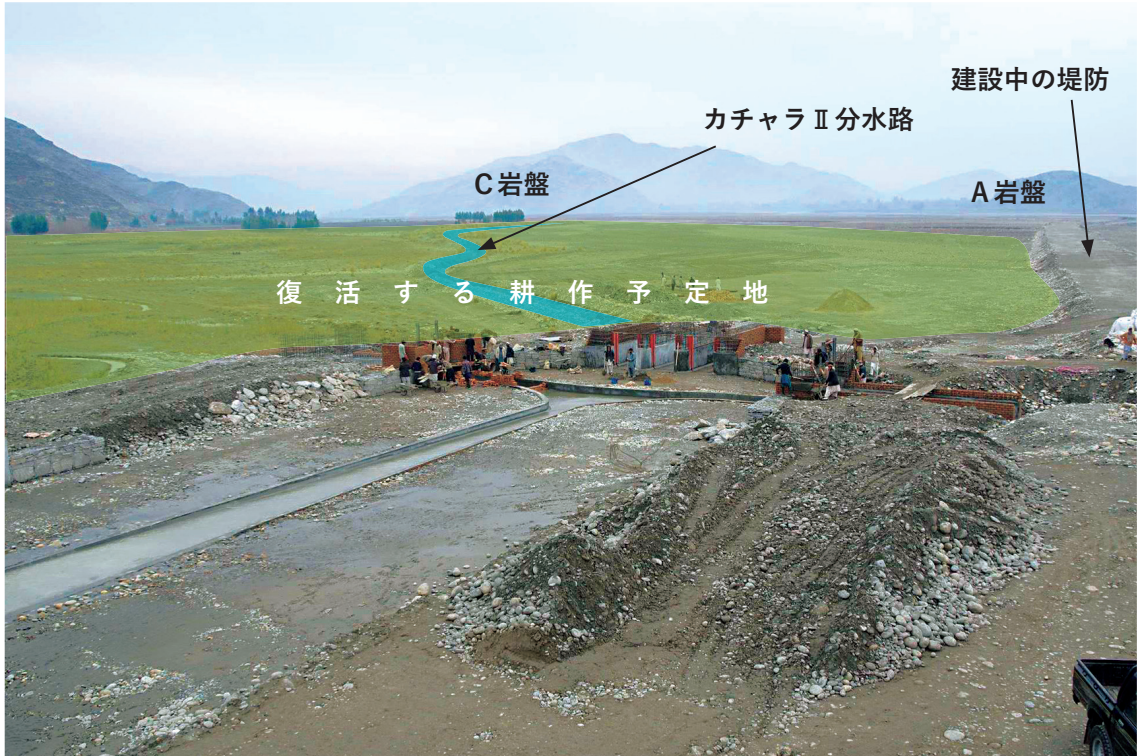
沈砂池下流部とカチャラ第2分水路。グリーン部分が全部畑になる。流域はかなり広く、現在、新農地の面積を測量中(2017年1月29日)
