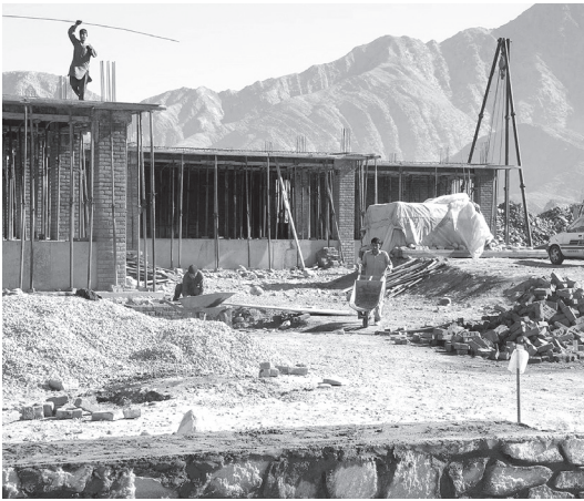
建設中の訓練所(2017年3月)
