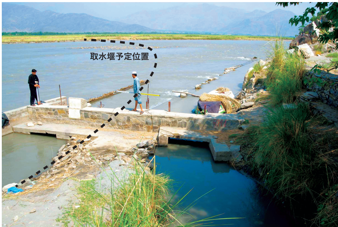
マルワリードⅡの取水堰建設予定地（カチャレイ村）。手前に岩盤が張り出し、対岸に長大な（長径約950m）単砂州がある。対岸はシギ村落群が広がる（2016年9月22日）
