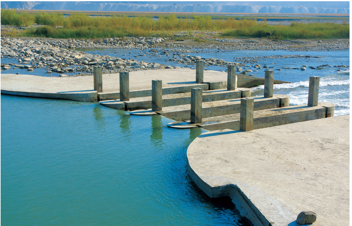
ミラーン堰で初めて試みた堰板方式の河道堰（砂吐き、洪水吐き）。10月下旬、河水位の異常減少で取水不可能に陥ったが堰板を挿入し取水を回復した（2016年11月14日）
