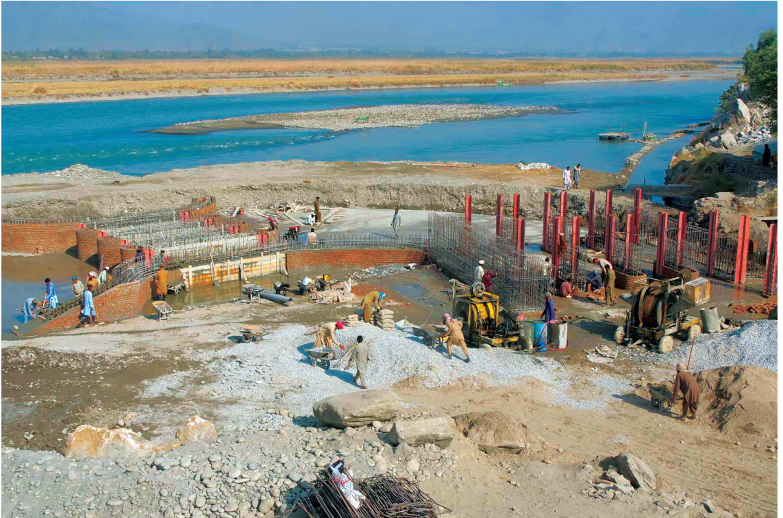
建設中のマルワリードⅡ取水門（右）、土砂吐き（左）（2016年10月）
