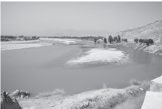
今夏の洪水で移動して来た砂州。ベスード第一堰上流。秋から堰と共に改修工事を開始する
