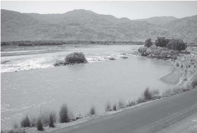
マルワリード堰。対岸カシコート堰と連続し505m。両堰とも取水量は安定している（2016年8月24日）
