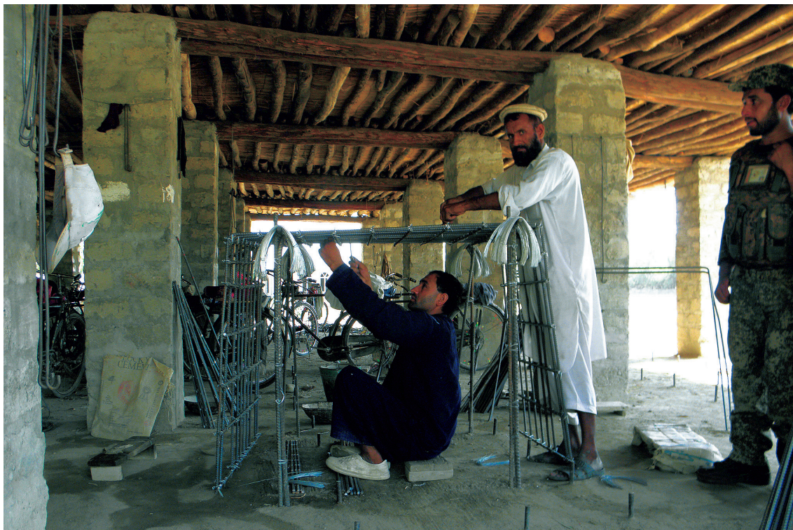
ガンベリ農場のワークショップで主幹排水路用U字溝の鉄筋組みをする作業員たち
