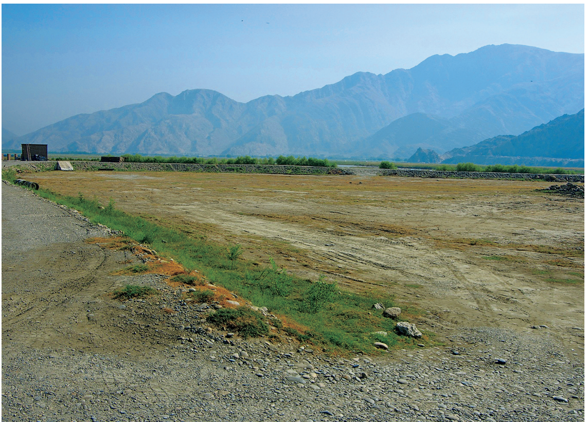
整地が始まった研修所建設地。9月中に鍍入れ式が行われる。左奥にミラーン堰の水門番小屋が見える（2016年9月）
