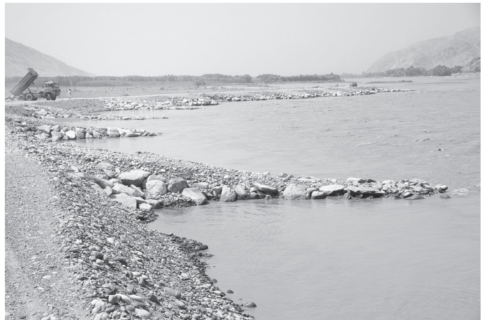
クナール河左岸（ミラーン堰上流対岸）の洪水流入路の護岸堤2.4km。今秋この上流にマルワリード第二堰の建設が開始される
