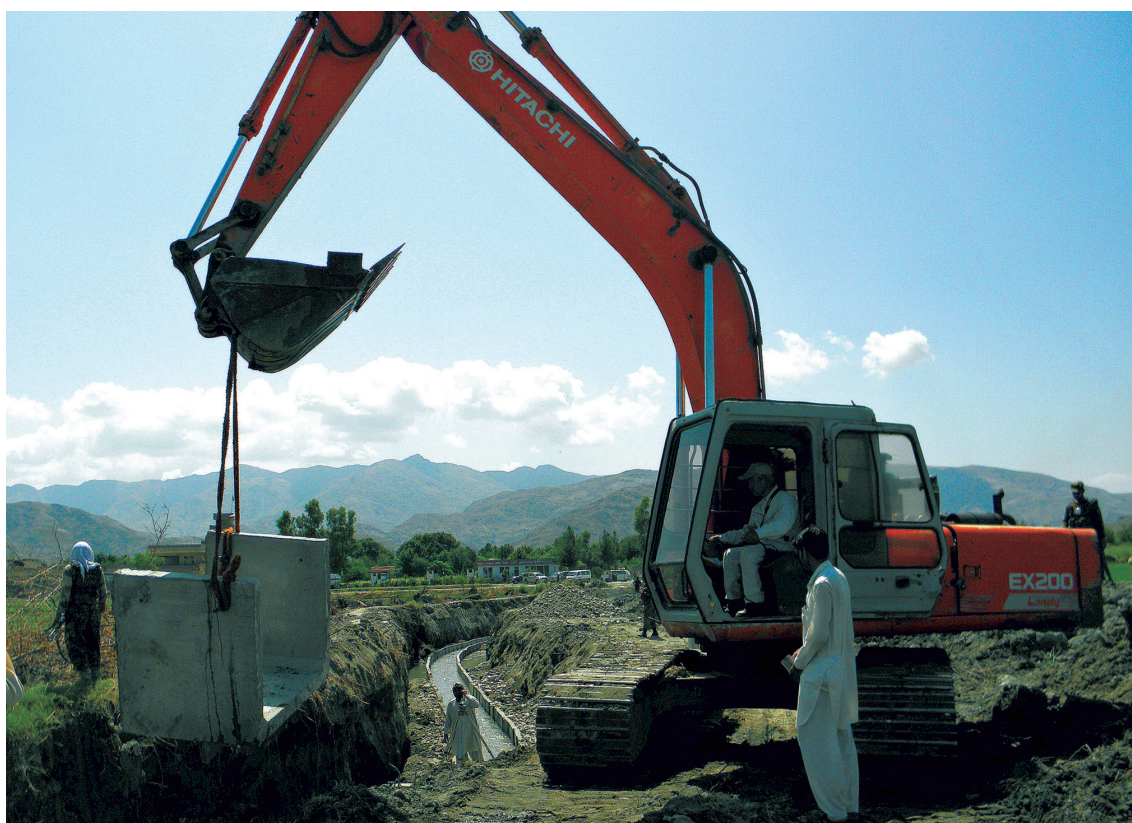
主幹排水路にU字溝を降ろす中村医師。1770mの主幹排水路工事は、ワークショップ（写真上）や石材採り等の段取りで、滞りなく進行中である（2016年7月）
