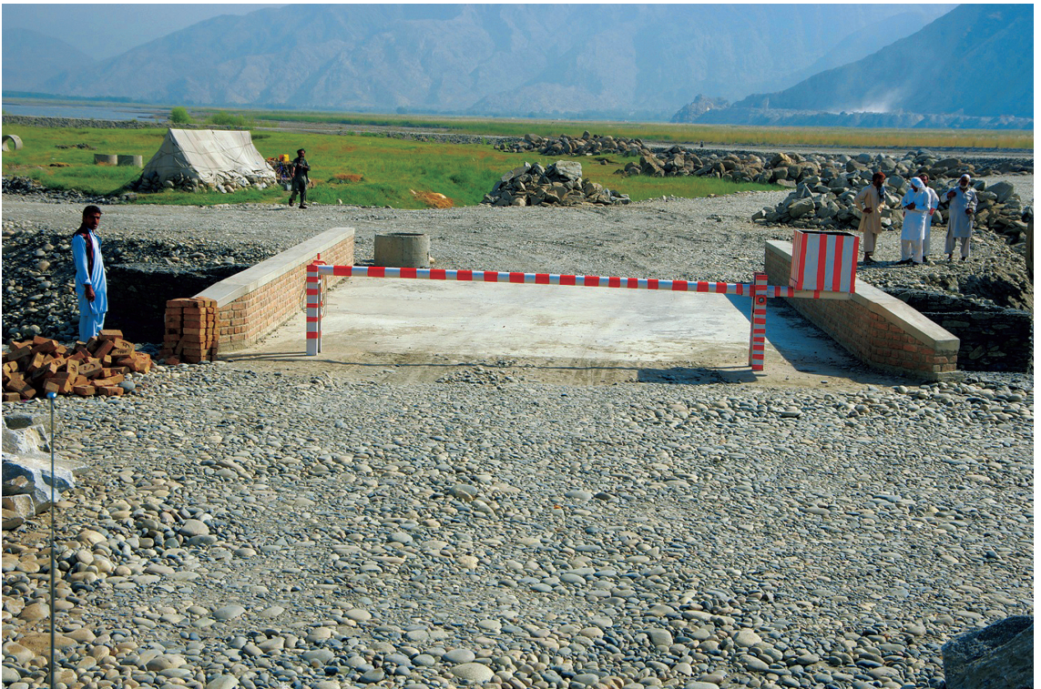
ミラーン排水路末端に交通路として掛けた橋が完成。奥には、護岸堤の補強と、今夏の洪水による堰の改修や研修所建設に使用する巨礫の蓄積が見える。河の水位が低下する秋から取りかかる。
