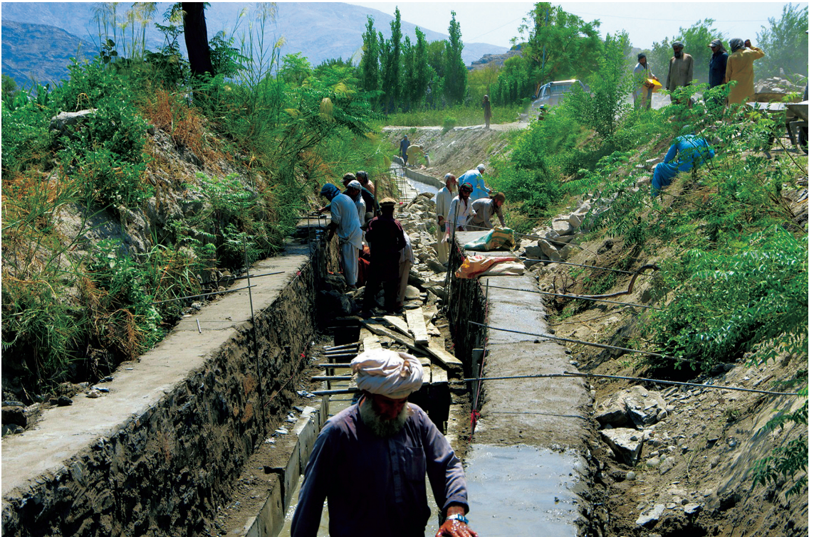
主幹排水路建設中の職員及び作業員たち（2016年8月24日）
