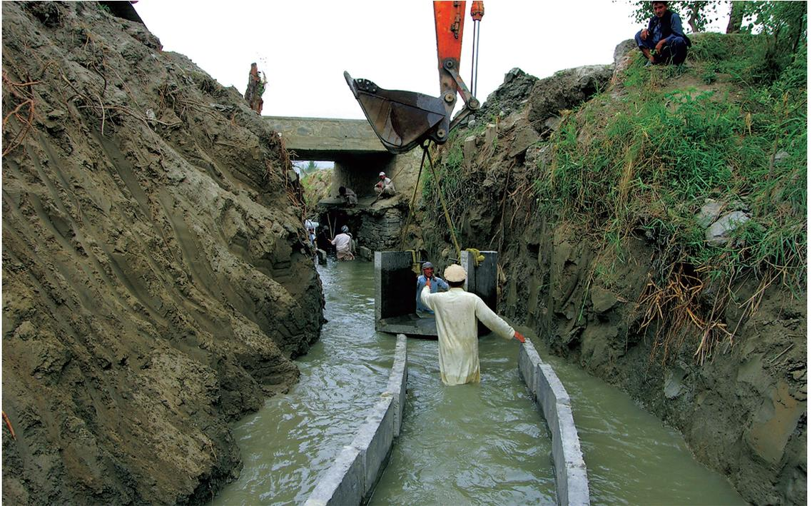
排水路幅は様々で柔らかい土質の場所が多い。土地の問題で排水路幅を広げない条件下、下手にやると両岸が崩落する恐れがある。水路床中央にU字溝を置き両岸にかかる掃流力を減殺させ根固め工と組み合わせる（2016年5月2日）
