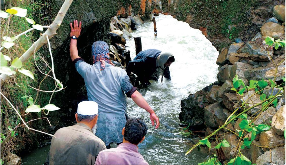
まず水底の状態を調査。排水路は全長1500m、落差3.1m（傾斜約1/220）の激流。10年以上一緒に働いた作業員は動じず作業に挑む（2016年3月17日）
