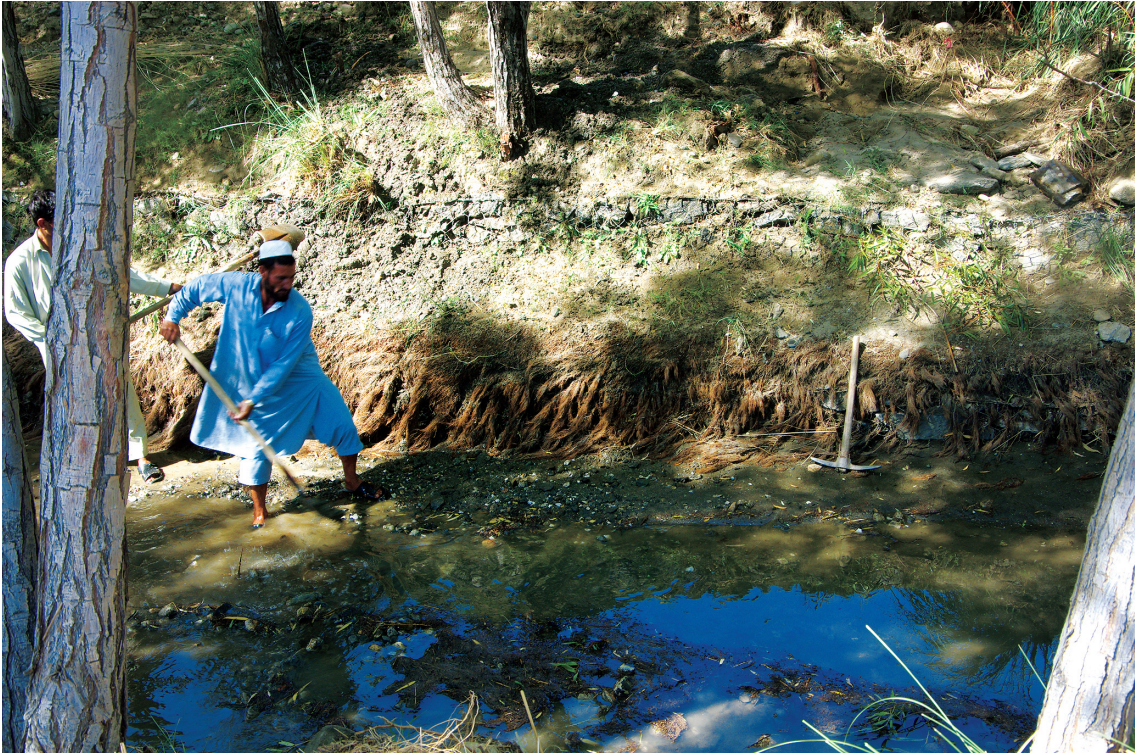
用水路浚渫中。2段目の蛇籠の背面に柳を挿し木して7年後のマルワリード用水路。蛇籠の石は柳の根で見えない。周りの樹の幹は成長した柳である（2011年10月12日）
