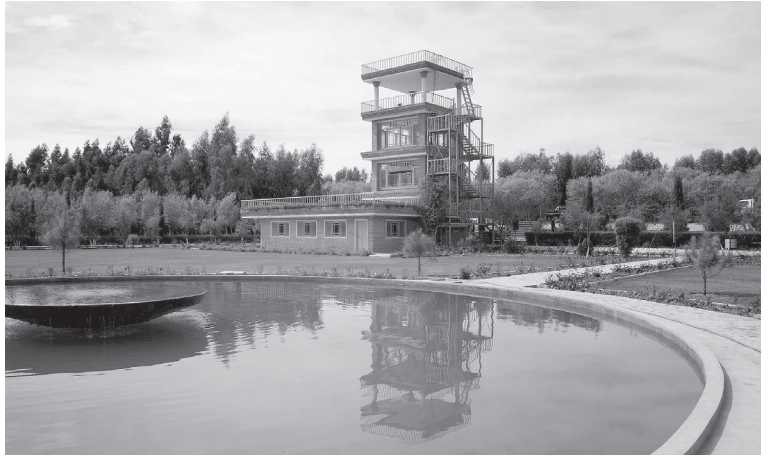
ガンベリ沙漠に建設したPMS農業事務所。職員と地域の作業員、そして無数の協力によって造られた（2016年3月17日）
