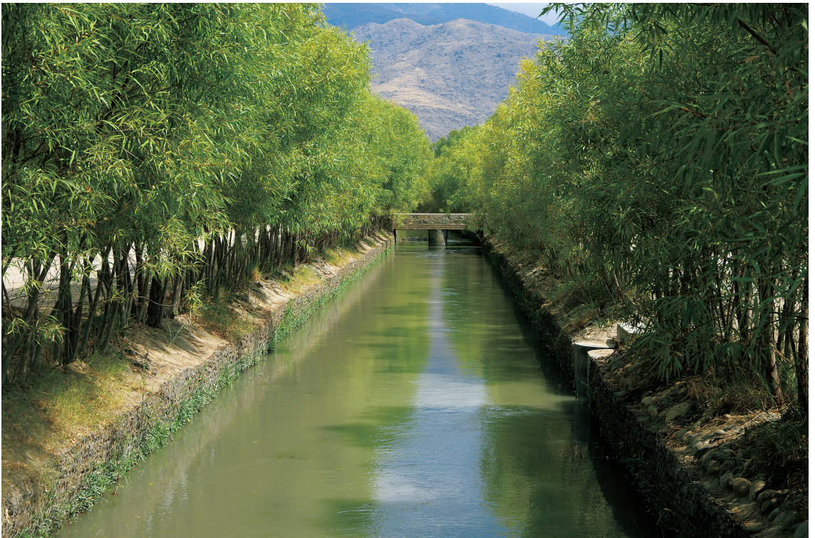
ガンベリ横断水路。蛇籠工と柳枝工を施した用水路。柳がこの位成長すると蛇籠の石の間に根がびっしり入り込み、水やりは要らなくなる（2015年7月11日）
