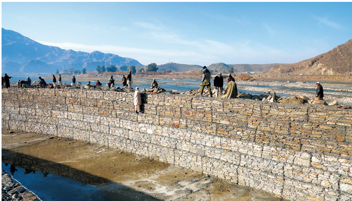
カシコト主幹水路。地域の作業員たちの労苦によって積み上げられた蛇籠は壮観(2013年1月14日)
