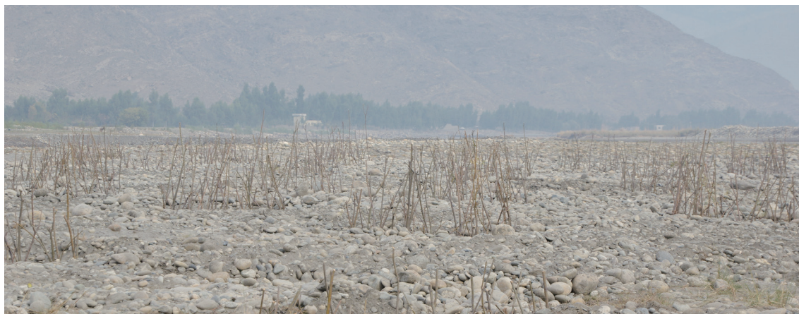
ミラーン堰工事では、新たなころみとして、砂州固定に柳枝工が施された（2015年11月19日）
