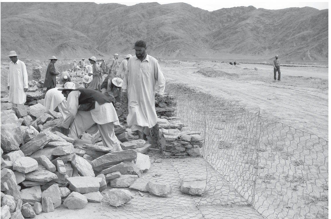
上のワークショップで編んだ網を、現場で石を積みながら籠にする。用水路の殆どの両壁に使用されている
