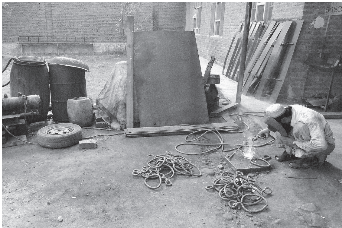
ジャララバード事務所のワークショップ。堰板の上げ下ろし時に使う道具を作製中。周りに堰板に貼り付ける鉄板や、鉄板をつけ錆止めを塗って干している堰板が見える。水車もここで作った。
