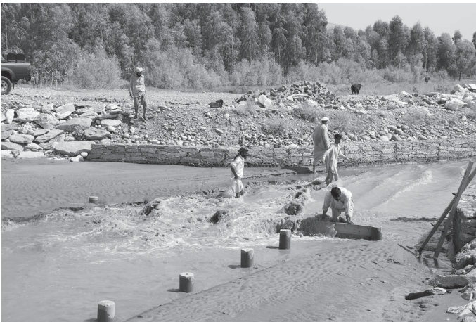
洪水で大量の土砂が流入した沈砂池の浚渫作業 (2015年7月)
