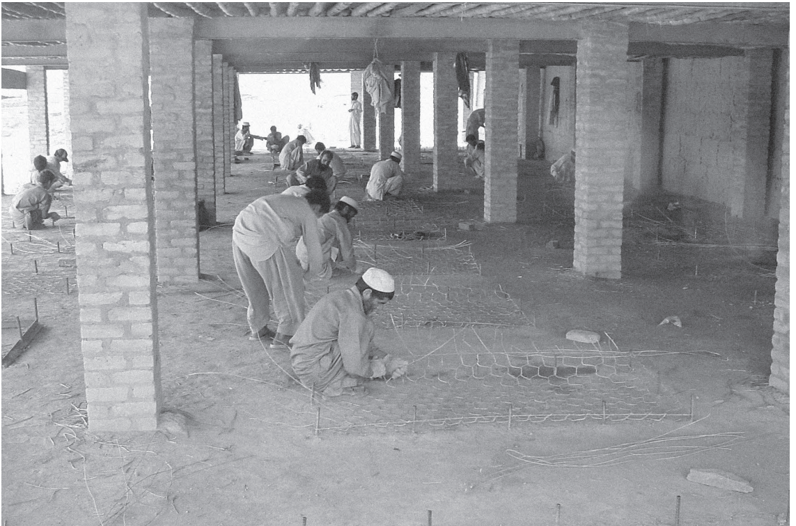
蛇籠ワークショップ。2003年、用水路建設当初は賞金つきのコンテストを行い、技術向上を図った。現在はみな熟練工だ
