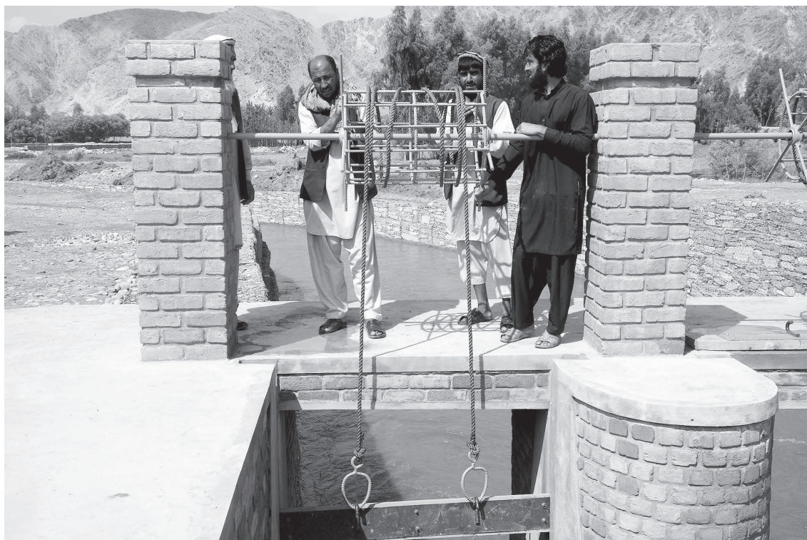
堰板方式取水門。堰板の上げ下ろしを指導するエンジニアのファヒーム（左）
