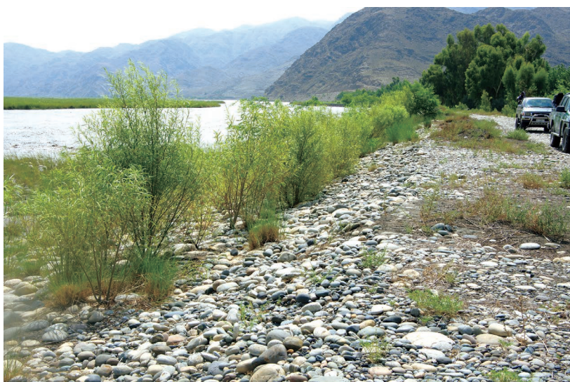
左：洪水流入地に柳やユーカリで樹林帯堤防を造成。外法10m、天端10m、内法10~15m（2013年3月）
