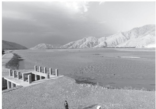
建設中のミラーン取水口（2015年7月）
