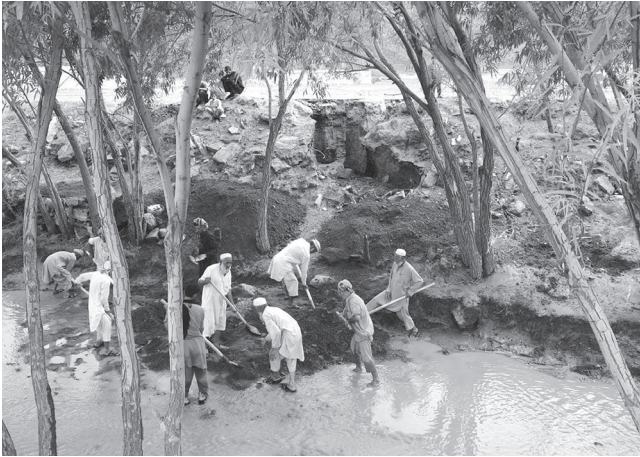
鉄砲水の後の修復作業。約10カ所で一斉に作業を進めている (2015年7月)
