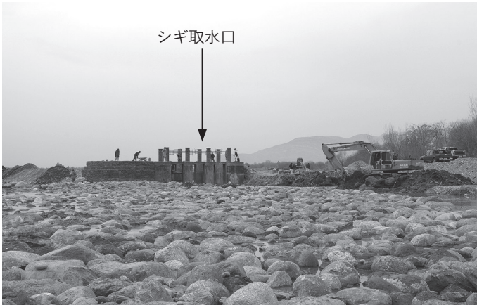
巨礫を置いたシギ堰。全体が扇状で中央が窪んだ形。高水位時の流れを引き寄せ、堰をかけた中州を破壊しないように取水門側から約20mを数センチ低くしている。2015年2月7日
