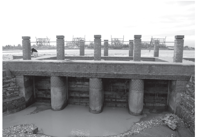
ベスード第I取水門—水門に嵌められた堰板でカブール河水深3m以上の洪水流入を許していない。2015年2月25日
