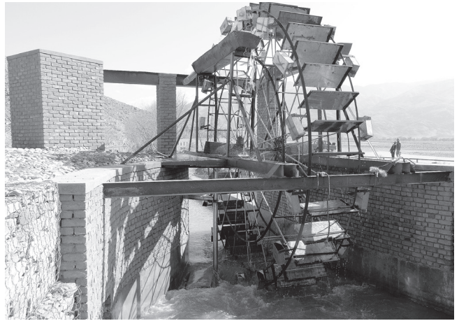
今年カンレイ村に設置した直径6mの揚水水車2号機。用水路底から5.2m汲み上げ灌漑する
