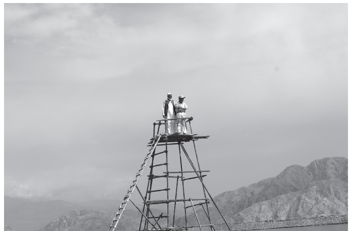
ミラーンの現場は視認できる手頃な高台がないので、急ぎょ作業範囲全体1.2kmが見渡せる5mのやぐらを組んだ
