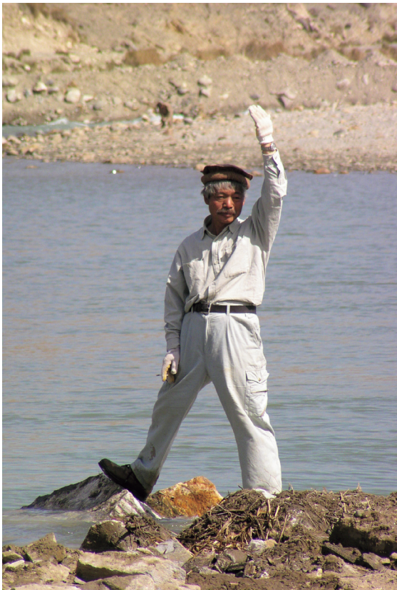
マルワリード堰の先端へ重機を誘導する中村医師
