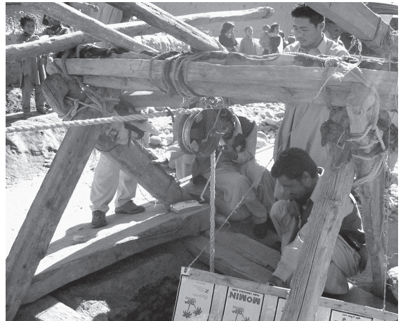
井戸掘削現場での蓮岡O B (右上。2002年4月)
