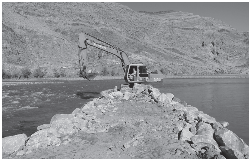
洪水の激流をかわす水制を造る中村医師。カシコート取水門から上流1km地点(2014年2月)
