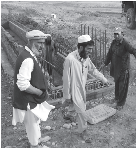
シギ下流域の灌漑に分水路を引く(左がムヒブラー現場監督)
