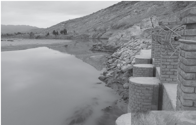
15cmの超低水位でも潤せるよう設計されたベスード第一堰だが、河川の増水期に3cmまで低下。臨時改修を行った(2014年3月3日)
