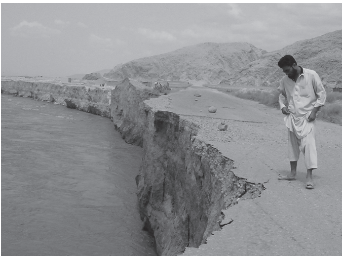
クナル河左岸の主流閉塞のため、右岸へ流れが押し寄せ洗掘され国道が崩れた。国道の右側にPMSの用水路E区がある。
