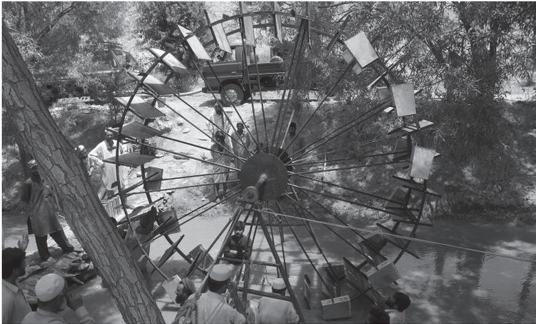
試験設置した水車 設計は朝倉の水車に基づいている
