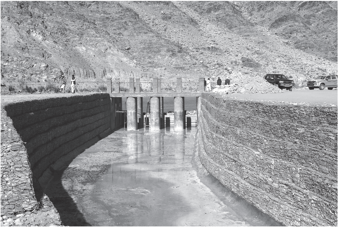
完成したカシコート取水門を用水路内から見る（2013年1月26日）
