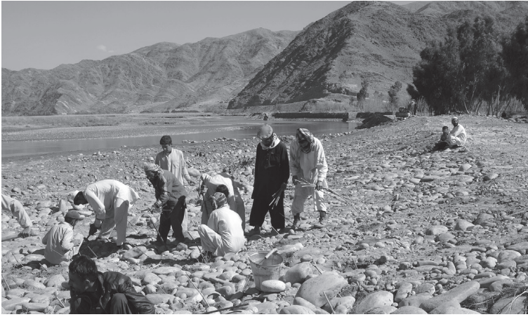
カシコート上流の洪水流入地の護岸工事（柳の挿し木中）。河の表法に緩傾斜をつけ巨礫間に柳の密植をする（2013年3月8日）
