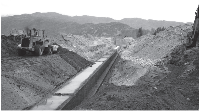
完成したシギサイフォン260mの埋立作業。9カ月の苦勞が、見えなくなるのは寂しいと作業員の弁 (2013年1月31日)
