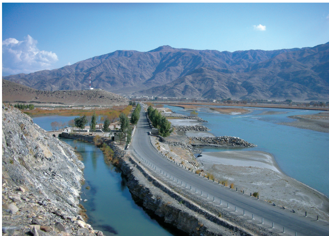
D地区D池付近。上は用水路をひく前の2003年4月、下は2010年2月。国道右側に石出水制が3基見える
