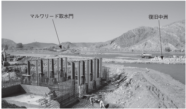
カシコート取水門の柱=堰板を積む溝 (2012年11月4日)
