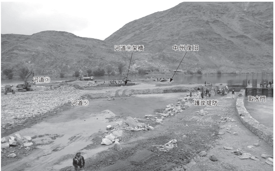
作業場が川べりに集中、河道⑤、護岸壁、取水門、河道④、中州復旧、河道③閉塞の、各作業
