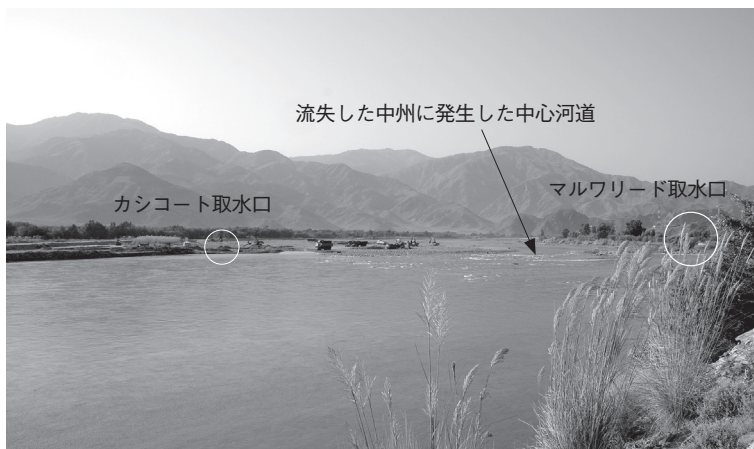
クナール河上流からみるカシコートとマルワリード取水口（幅は約 500 m）
