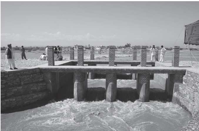
今年4月7日竣工したベスード第一取水口 堰板方式取水門4基・2列、斜め堰から幅8mの主幹水路へ取水される
