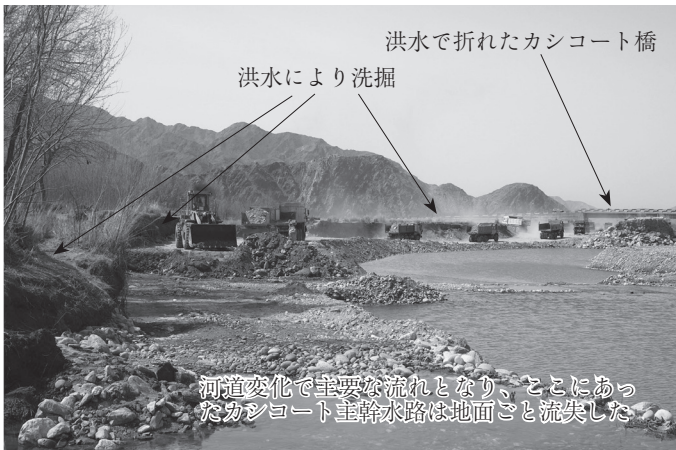
洪水で流失したカシコート主幹水路地点の埋立て
