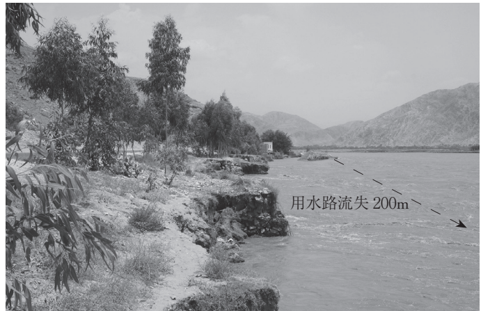
急激な雪解け（2年前の大洪水に匹敵）で既存用水路のベスード第二・タンギトウクチ帯は濁流に洗われた
