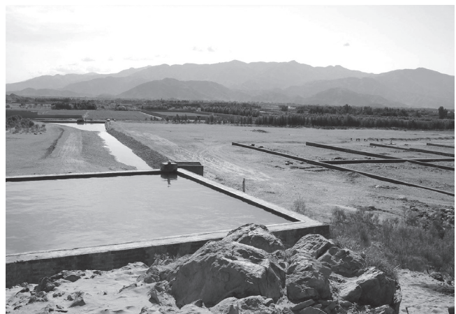
ガンバリ沙漠の給水塔（平和ヶ丘）。用水路の水を15m揚水し、傾斜を利用した水やりは防砂林の保全を容易にした（2012年4月）
