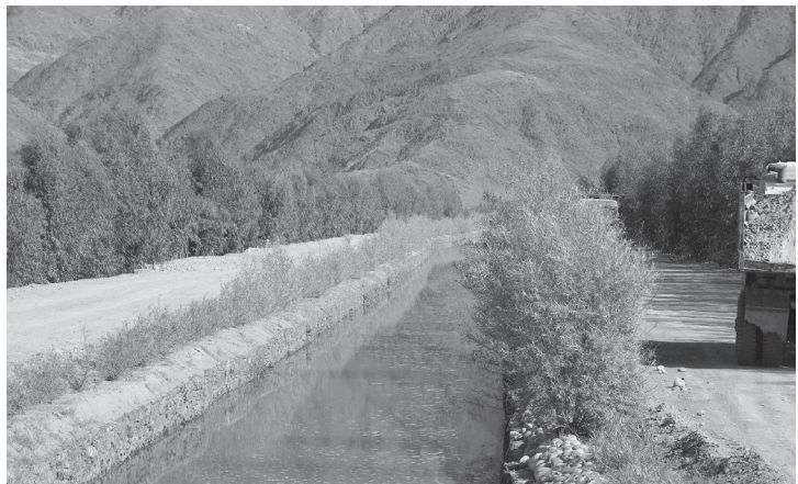
沙漠横断水路。木々の成長で、主幹水路が砂で埋めつぶされることがなくなり、年を重ねるごとに用水路は強くなっている（2012年4月）
