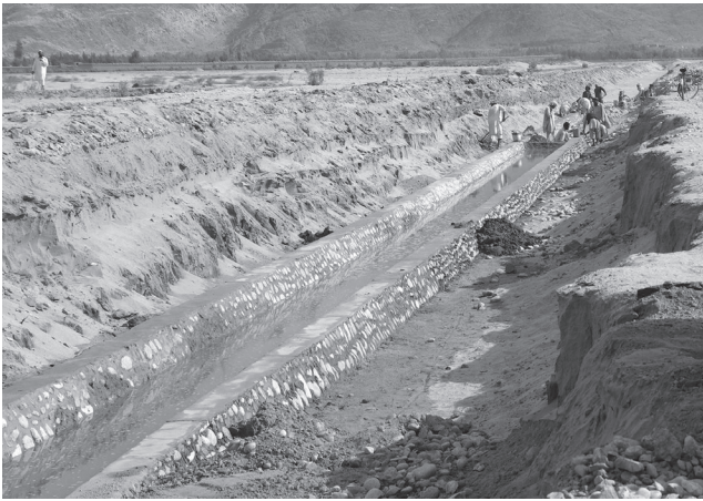
ガンベリ沙漠の排水路敷設工事。排水路が整備されると、湿害の心配がなくなり、農場の開墾地を増やすことができる（2012年4月）
