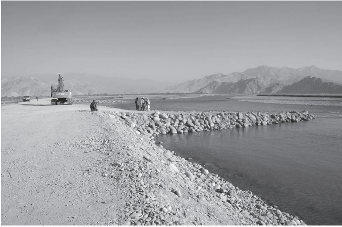
ベスード護岸—石出し水制群。40mの水制にダンパー500台を投入した (2011年11月)
