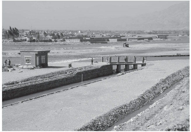
ベスード第一取水口。カーブル政府灌漑局の調査団は、これを完全に新しいシステムと高く評価した（2012年2月）
