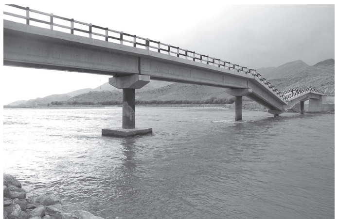
2010年夏の大洪水で折れたカシコート橋
