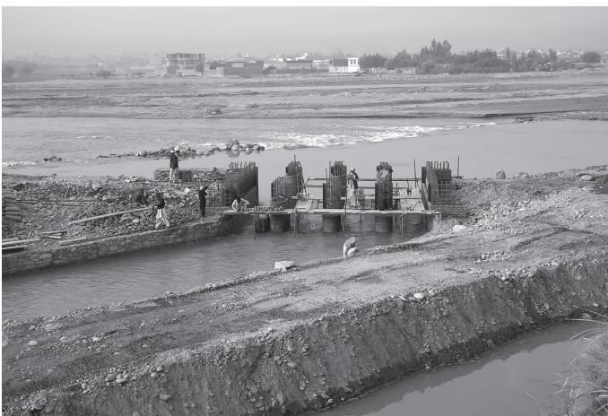
通水後のベスード第1取水門。田畑に水を流しながらの水門上部工事
