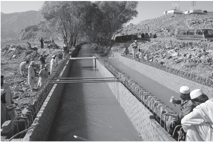
ジャリババ溪谷洪水通過路（A地区用水路を横切る）の拡張工事。水を流しながら作業を進める。旧通過路の幅14mを35mに拡張。109号の掲載写真と同じ場所
