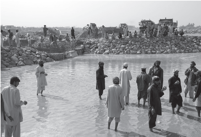
10月30日ベスード第I水路に通水。作業員も、祝いの菓子をほお張りながら、感慨一入。取水門からの主幹水路約170m下流にある沈砂池にて
