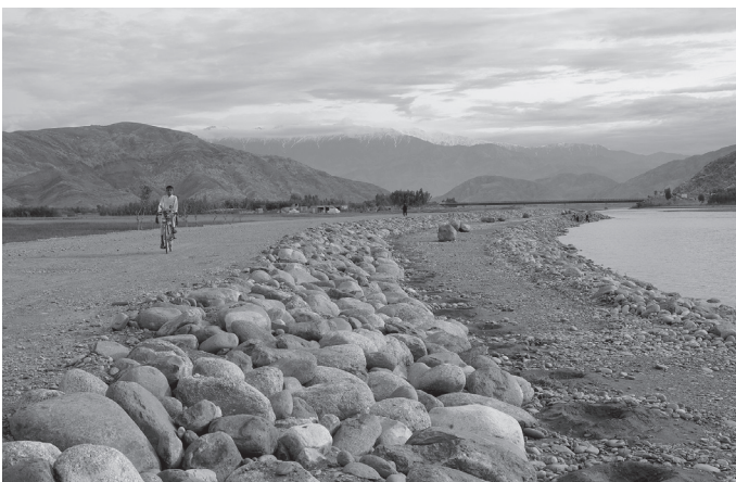
ベスード側の護岸工事。巨石による 1700 メートルの捨石工。昨夏の大洪水余裕高を洪水レベルより 1.5 メートル以上とる。
