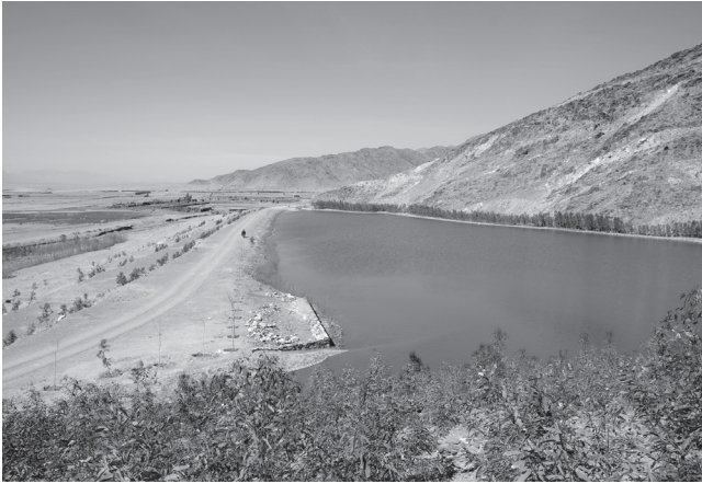
Q 3池。全長 25.5 キロのうちこのような貯水池・遊水池が 12ヶ所造成された。池の向こうはガンペリ沙漠。
