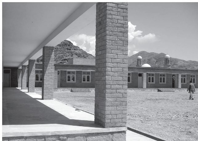
完成したマドラサの寄宿舎
