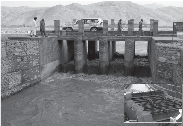
カマ第2取水口。2列の堰板から階段状に水が落ちる。右下の写真がレバノン杉を用いた堰板。厚さ5センチに鉄板を貼付けて浮力を殺す。
