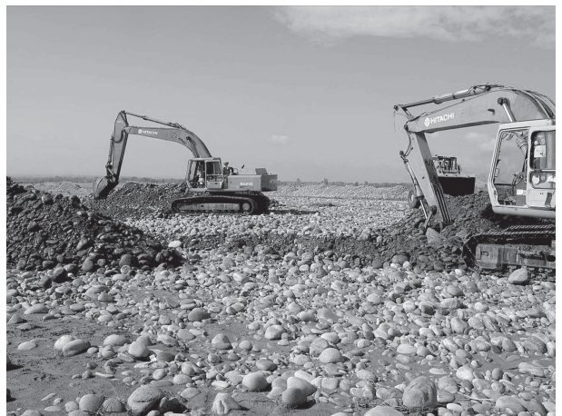
クナル河の主流河道回復工事
