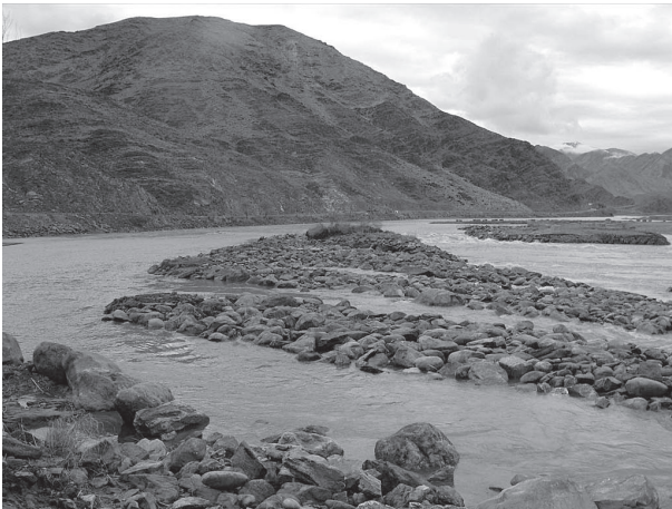
改修工を終えたマルワリード取水堰
