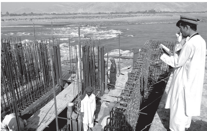
カマ第2取水門建設をすすめる鈴木ワーカー
