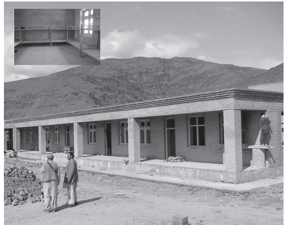
マドラサの寄宿舎建設は最後の段階。2段ベッドも準備（左上）
