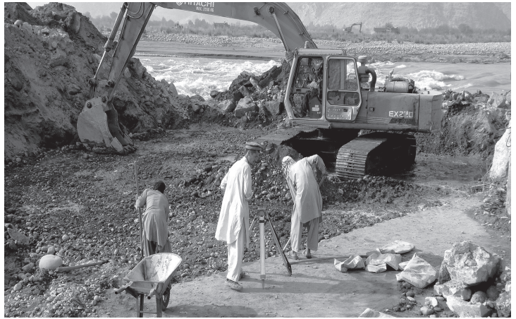
カマ第2取水門設置作業中の鈴木ワーカー
