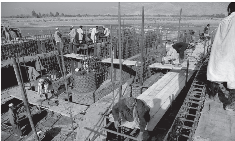
鈴木ワーカーの現地到着と同時に始まったカマ第2取水門の工事
