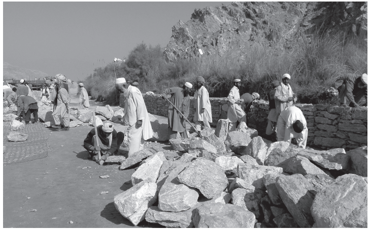
護岸のための蛇籠づくりに励む現地作業員たち（カマ第2取水口近く）
