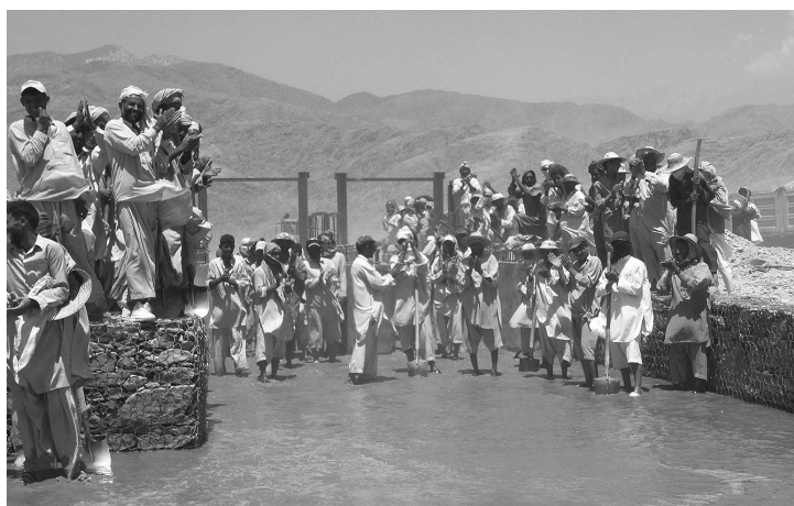
用水路全線開通で喜び合う作業員たち
