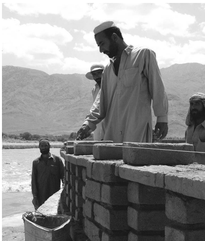
用水路の左官工事をするサディク
