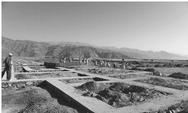
ガンベリ沙漠の開拓団居住区。各戸は約227坪(750㎡)。六戸ごとに2本の井戸。集落の長さは約1kmの長い村。手のかかる礎石は終わり、壁の造成が始まった
