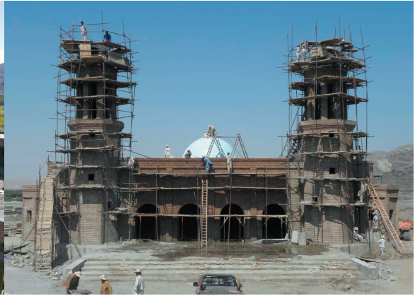
建設中のモスク。完成目前のミナレット（塔）
