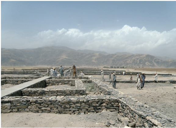
自立定着村で進行中の、各戸の区画壁と基礎の造成工事
