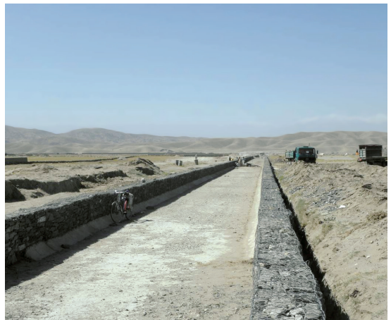
2.5キロ地点まで完成したガンベリ砂漠横断道路
