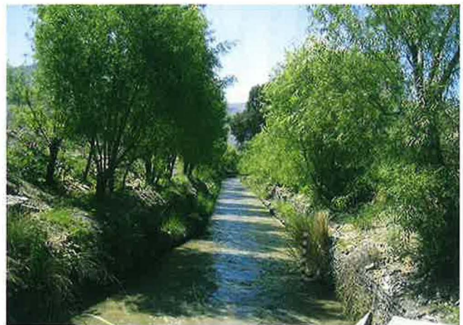
蛇籠で護岸した用水路。17 万本以上の柳を植樹
