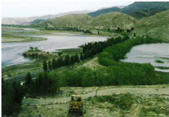
D沈砂池の柳も繁る。左手クナル河につき出した石出し水制
