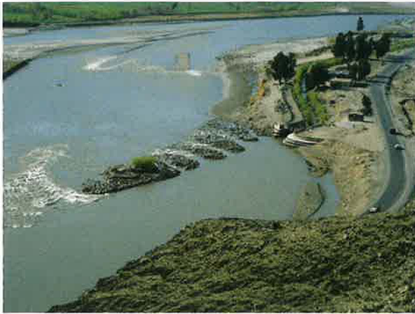
クナール河の取水口と斜め堰
