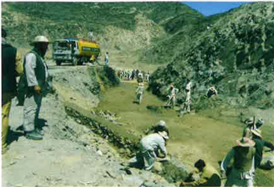
岩盤まわりの難工事Q1池
