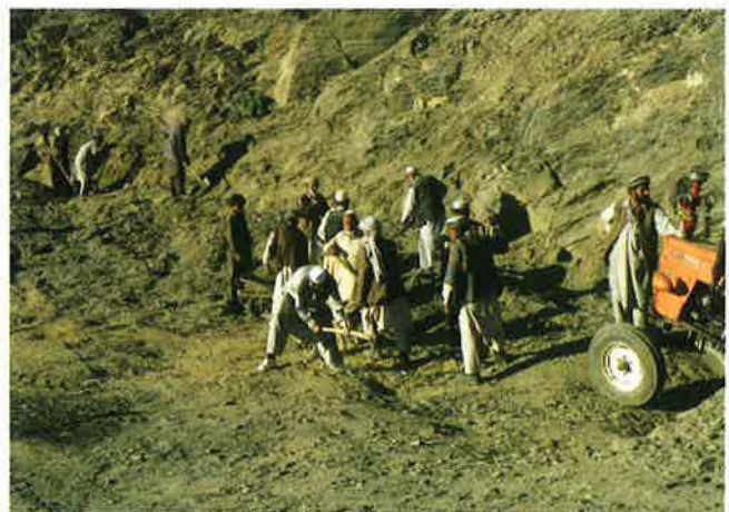
難行を極めた岩盤まわりの工事
