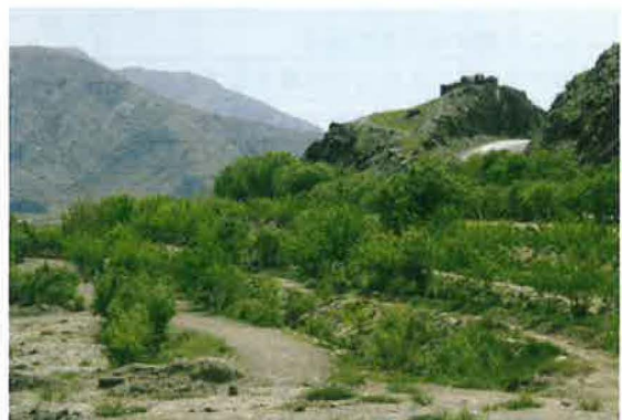
難工事のG岩盤は、階段状の盛土をして水路を通した。地盤の軟化を柳が防ぐ
