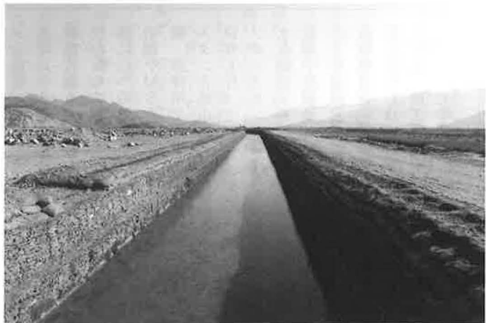
数回の土石流により改修を重ね安定した用水路P地区
