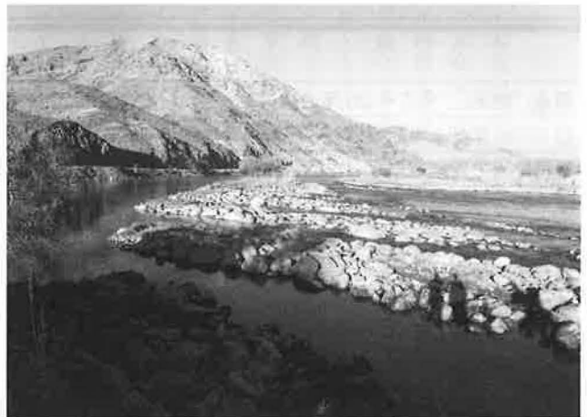
水位の異常下降により河床が露出したクナル河の取水口
