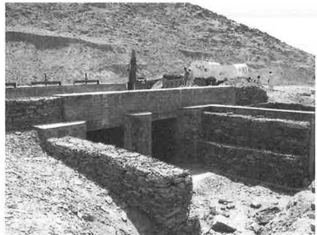
用水路の最終Q工区に建設中の水門
