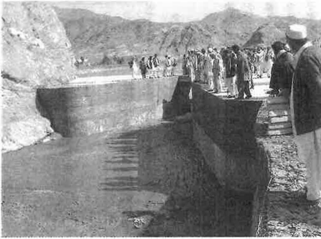
完成したシェイワ用水路の取水口
