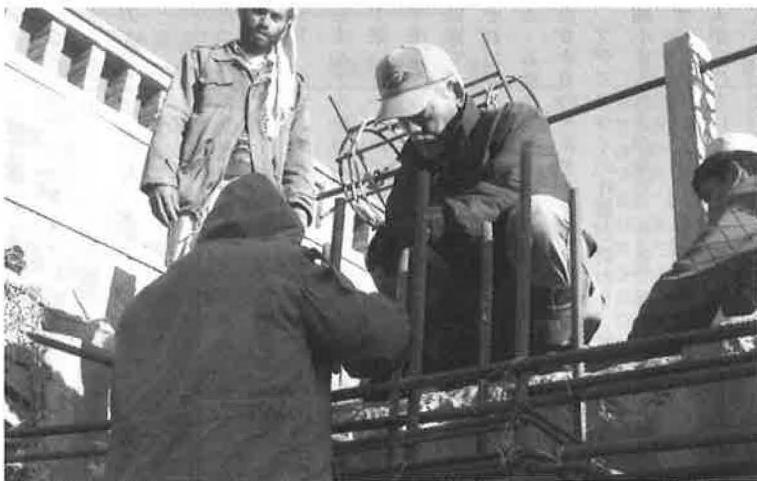
用水路取水口の改修工事中の鬼木ワーカー
