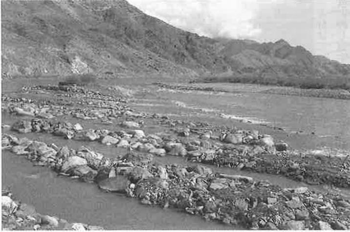
1600トンの蛇籠を擁して完成した強固な取水口
