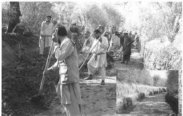
今年7月の土石流による土砂を取り除く現地作業員（右下は復旧後の水路）
