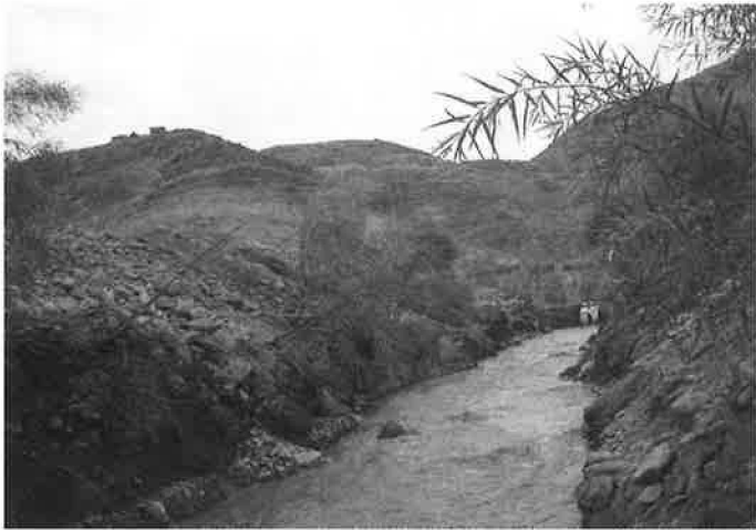
土石流に襲われた用水路。柳によって守られた蛇籠の護岸は無事だった
