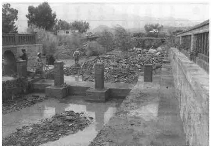
土石流によって埋った取水口
