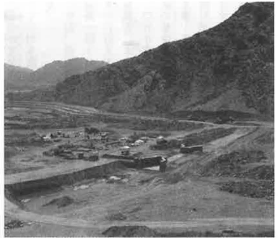
灌漑用水路の最先端工区に近い、 I地区の掘削作業現場
