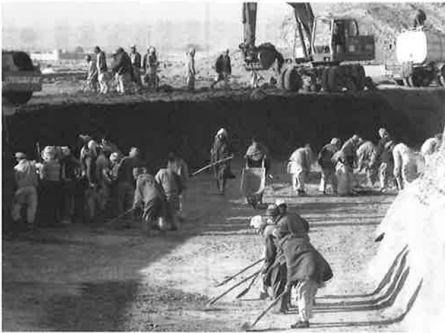
用水路は10キロ地点を掘削中
