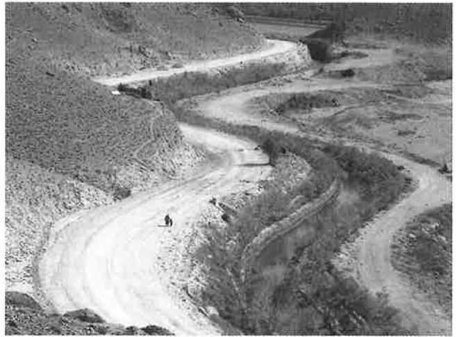
柳もしっかりと根つき、護岸の蛇籠を抱きかかえている
