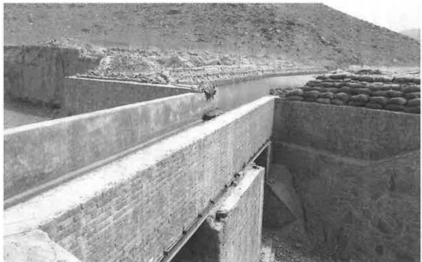
用水路D2地区にある水道橋
